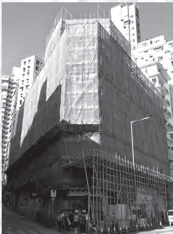
外牆重修時的情況
